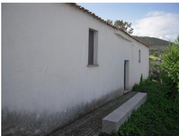
Fig.3: facciata parte a valle della Chiesa
